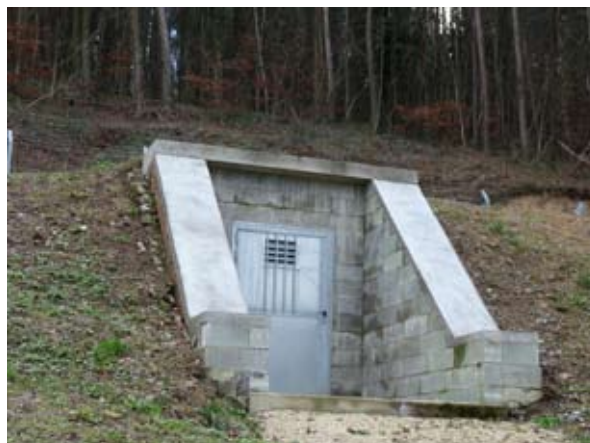
Le portail d'accès et la structure du captage d'eau de "Risque tout" viennent d'être achevés par nos employés communaux.
