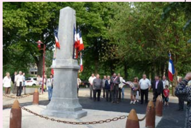
La célébration de l'appel du 18 juin, devant le monument aux morts en cours de restauration.
